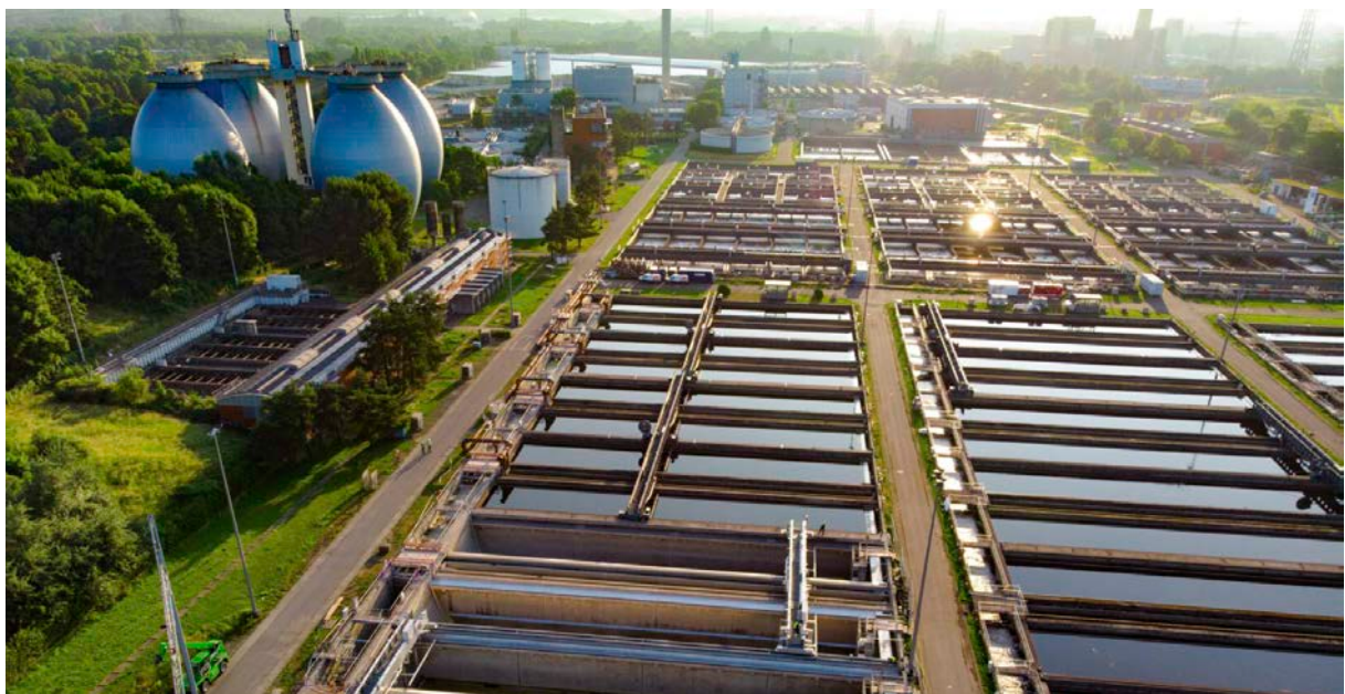
Kläranlage Bottrop (© EGLV)
